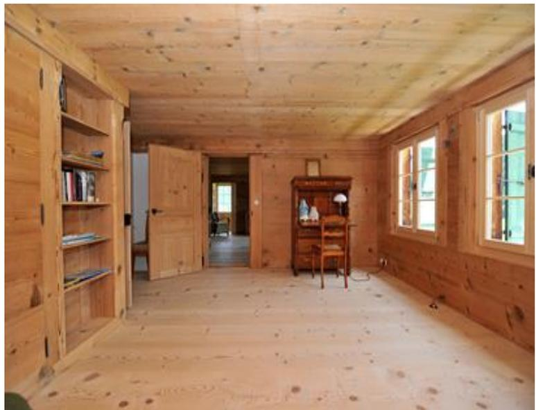
**Überschobene Wände/Decken 28 mm, Fichte massiv, gehobelt**
